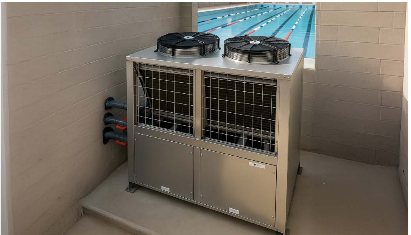
INSTALACIÓN TROPICALIZADA; GUAYANA FRANCESA
